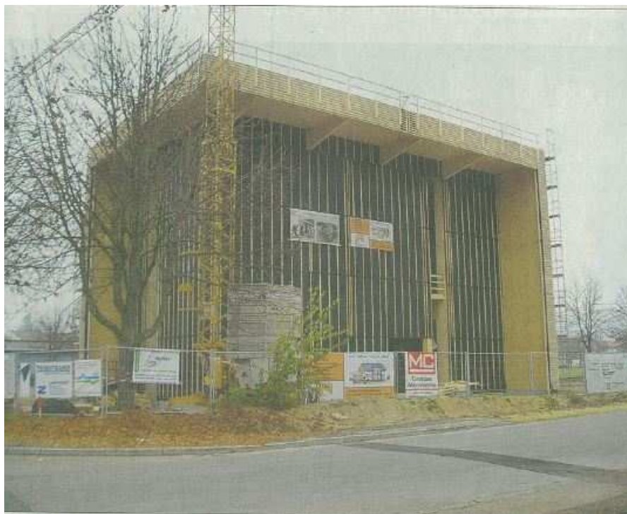
Das Gebäude ist in zwei Hauptkörper gegliedert. Im eingeschossigen 16 Meter hohen Baukörper befinden sich Kletterwände und Boulderflächen.
