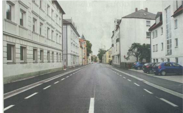
Mit einem neuen, lärmarmen Fahrbahnbelag präsentieren sich Johannis- und Stethaimerstraße. Rund 22 Wochen dauerten die Baumaßnahmen, während der die Straßen zum Teil vollständig gesperrt waren.
