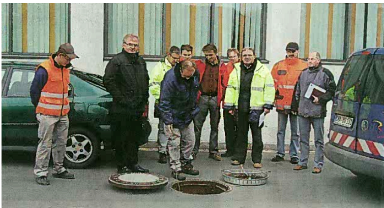
In der Schulstraße wurde mit der Abnahme der Baumaßnahme begonnen - Foto: Nicklas
