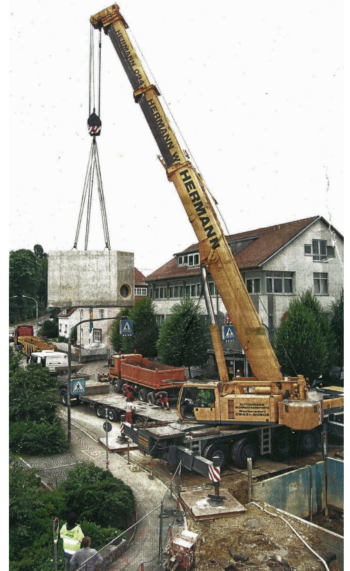
Das schwere Bauwerk wird über die Zebrastreifen-Beleuchtung hinweg eingehoben.
