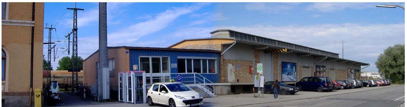
Derzeit befindet sich noch die alte Güterhalle auf dem zukünftigen Bauplatz, sie wird aber schon bald dem neuen Parkdeck weichen müssen
