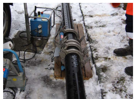
Gelochtes Druckrohr, PE 100, SDR II, 160 x 14,6 mm, beim Zusammenschweißen
