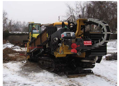
Mit Spezialbohrgerät wurden die Arbeiten aufgenommen
