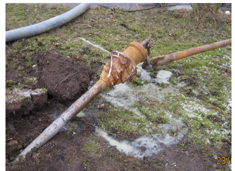
Konischer Räumkopf mit austretender Stützflüssigkeit
