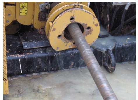
Pilotgestänge mit einem Durchmesser von 65 mm
