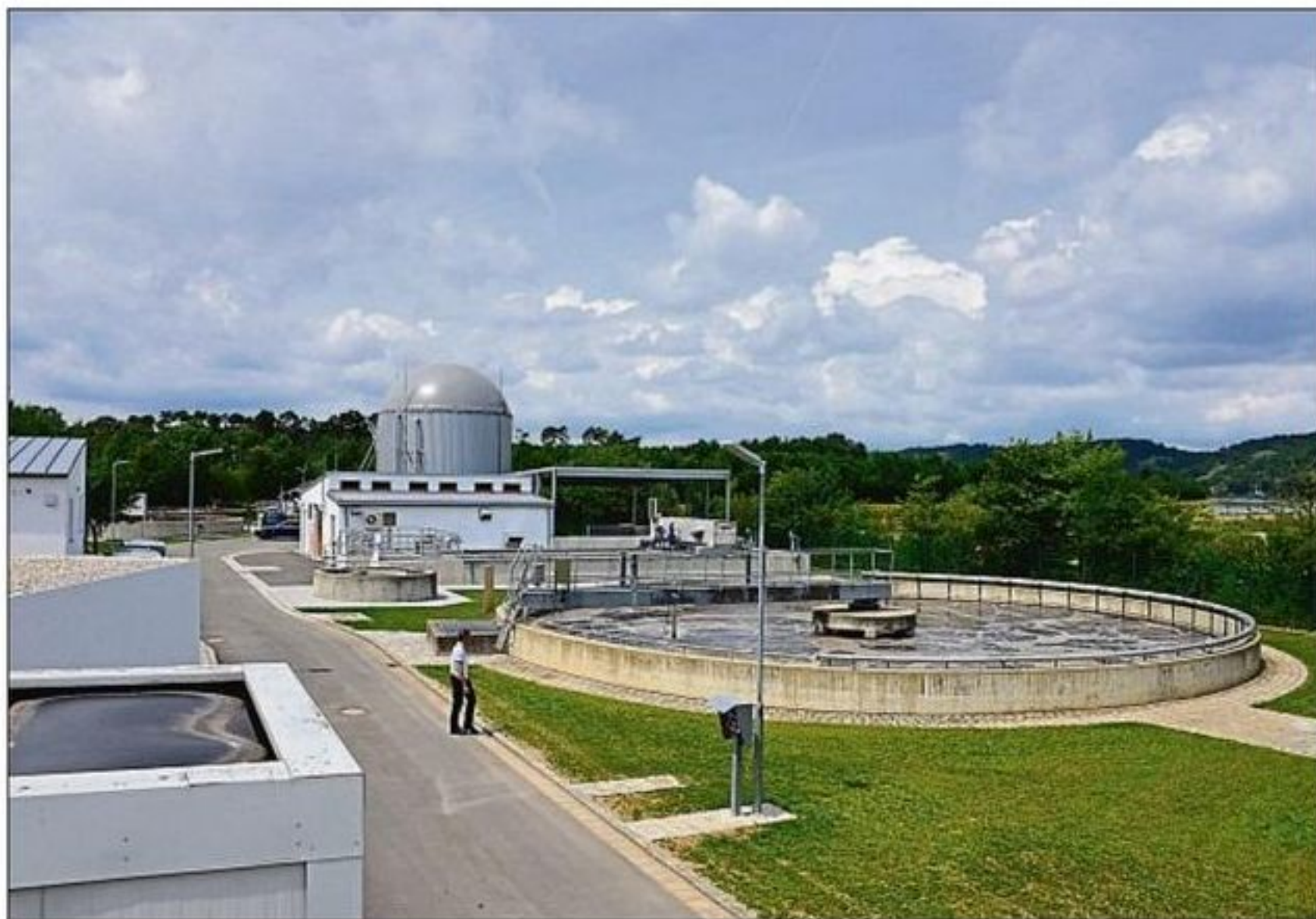
Die Kläranlage Bad Abbach.
