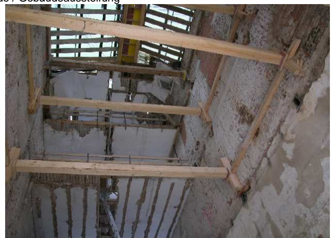
Abstützung Außenfassade / Gebäudeaussteifung
