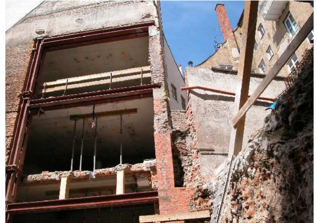
Einbau Abfangträger / Auflösung Kommunwand
