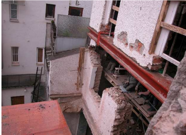
Einbau Abfangträger / Auflösung Kommunwand
