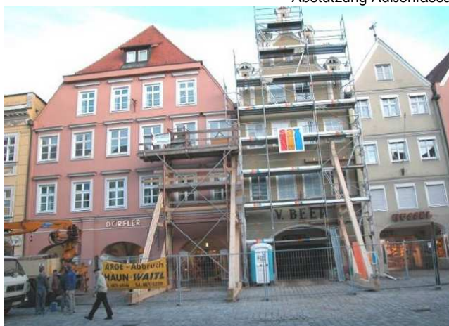
Abstützung Außenfassade / Gebäudeaussteifung
