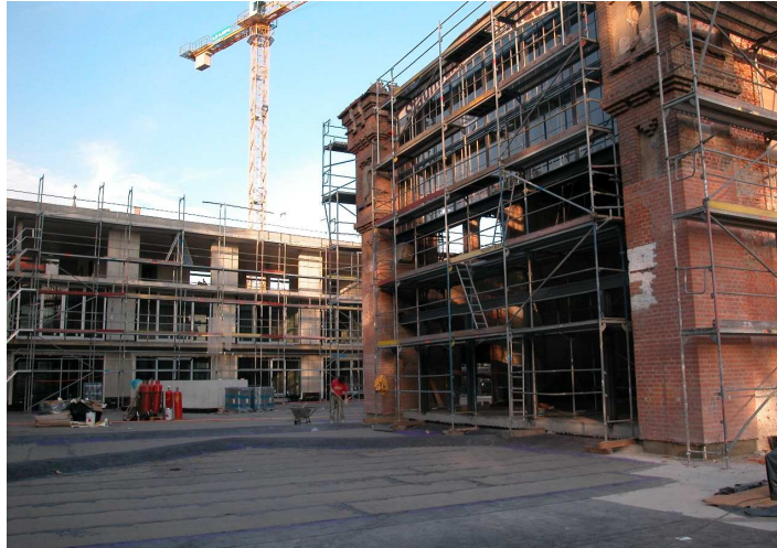
Markthalle und Haus A (Stand 09/06)
